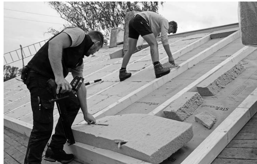
Energetische Dachsanierung eines Einfamilienhauses aus den 1950er-Jahren mit Holzfaser-Dämmstoffen
