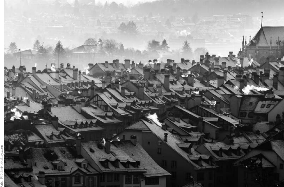
Die meisten der rund 20 Mio. Heizungsanlagen in Deutschland verbrennen fossile Energieträger.
