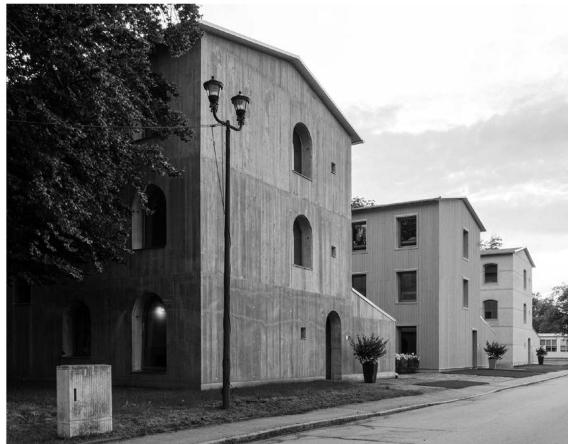
Die 3 Forschungshäuser in Bad Aibling weisen identische Grundrisse auf und wurden mit unterschiedlichen Baumaterialien errichtet: mit Leichtbeton, mit Holz und mit Ziegel.
