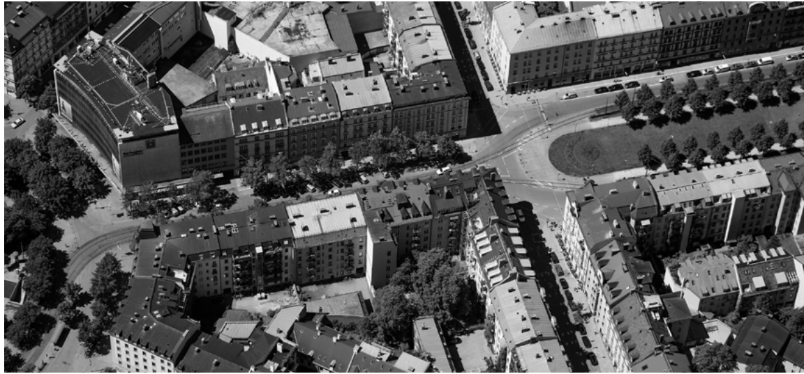
Gründerzeitviertel in München: Die hohe Bebauungsdichte wird als angenehm empfunden, weil sie kleinteilig und abwechslungsreich ist. Die hohe Bewohnerdichte ist Voraussetzung, dass die Nahversorgungseinrichtungen zu Fuß erreichbar sind und der Betrieb einer Straßenbahn ökonomisch und ökologisch sinnvoll ist.
